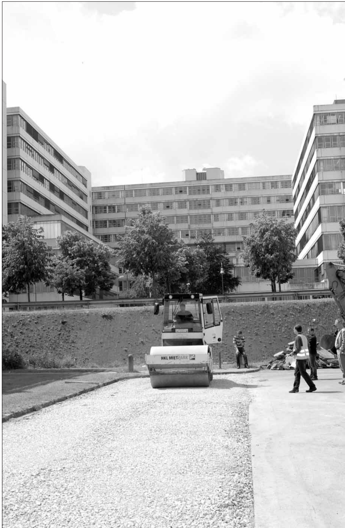
Schweres Gerät auf dem Parkplatz unterhalb der Uni: Mal schauen, wieviele Vibrationen Bagger, Walze und Lastwagen auslösen und wieviele Schwingungen im Hauptgebäude ankommen.
